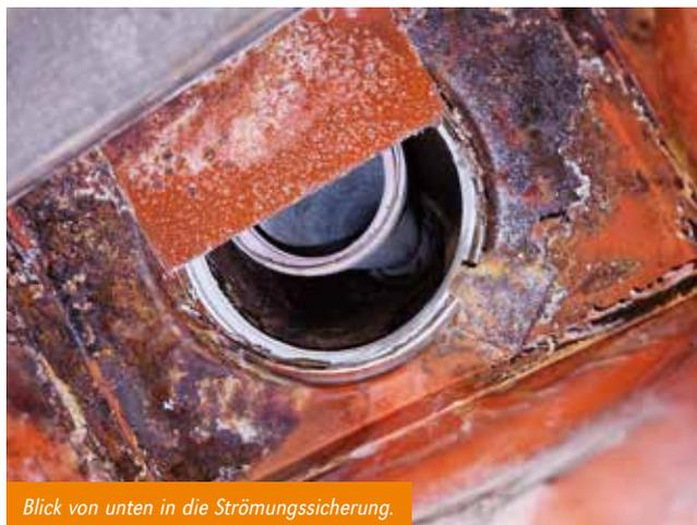
Blick von unten in die Strömungssicherung.
