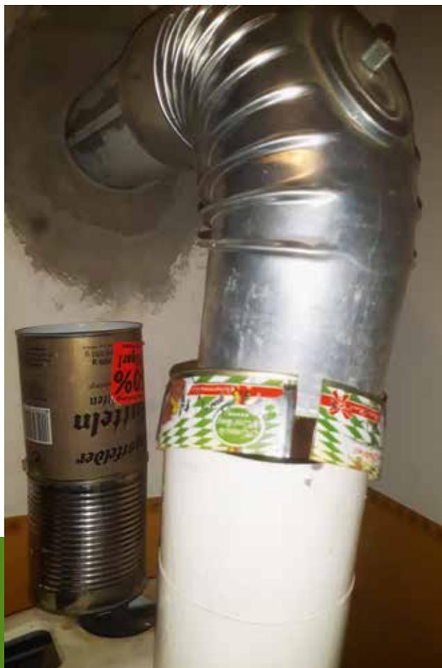
„Späßiger“ ist die Adapterlösung bei dem Gasraumheizer. Ob das Abgasrohr nicht mehr wegen differierenden Querschnitten oder zu kurzen Rohren passte, ist hier irrelevant. Die übergestülpte Wurstdose ist sicherlich keine Lösung – auch nicht übergangsweise.
