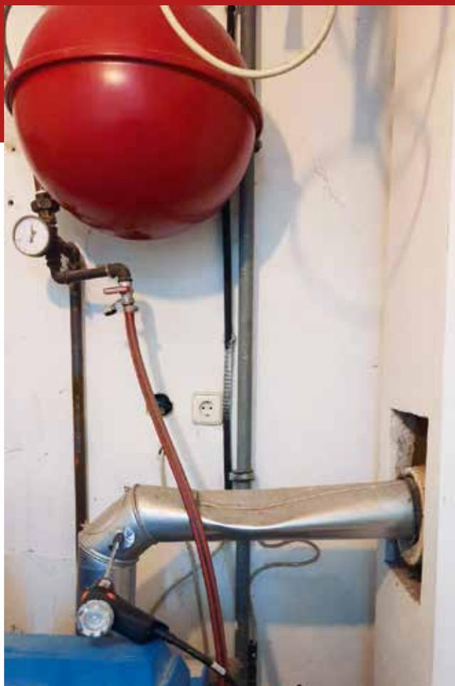
Bei dem Gasheizkessel ist das Ausdehnungsgefäß von oben aus der Halterung gebrochen und herabgefallen. In der Folge ist das Verbindungsstück der Feuerstätte erheblich deformiert. Hier hat der Kollege im Zuge der Abgaswegeüberprüfung sicherlich eine entsprechende Beanstandung formuliert.
